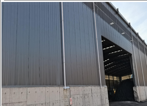
全封闭生产厂房
