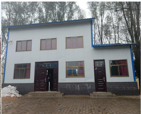
黎家河一泵站净水车间
