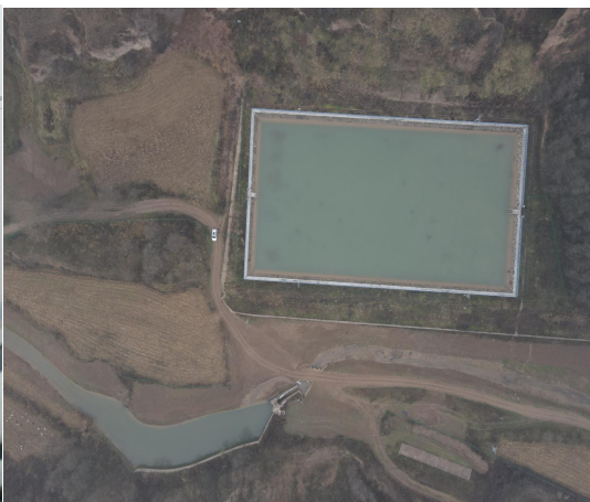
20000m 3 开敞式蓄水池、石护堤
