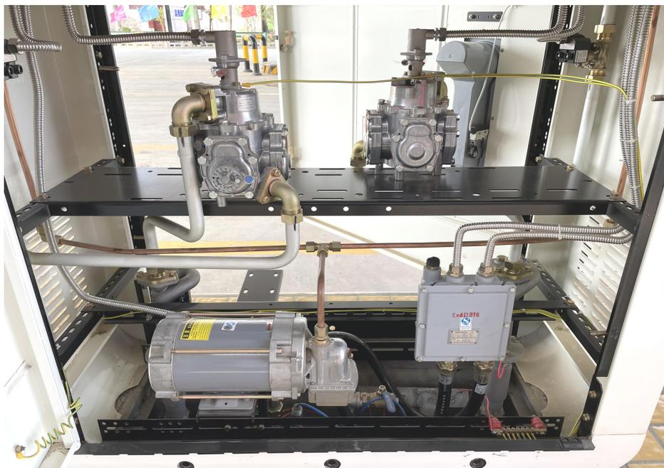
图 2-4 油气回收装置
