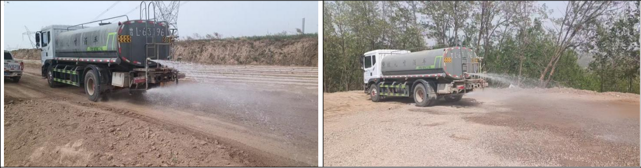
牵张场、临时道路洒水抑尘
