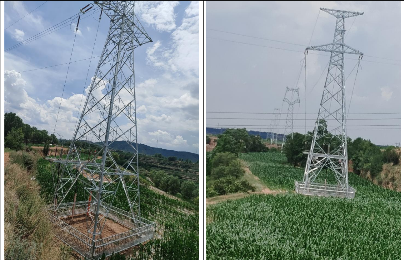
N16 塔基 N17 塔基
